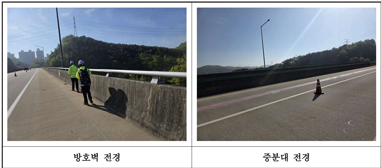
【사진 31.3.24】 방호벽 및 중분대 전경
