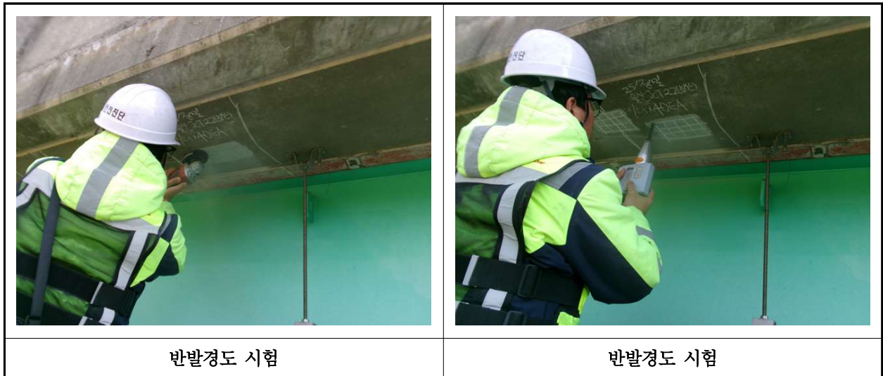
【사진 31.4.2】 반발경도시험 현장사진
