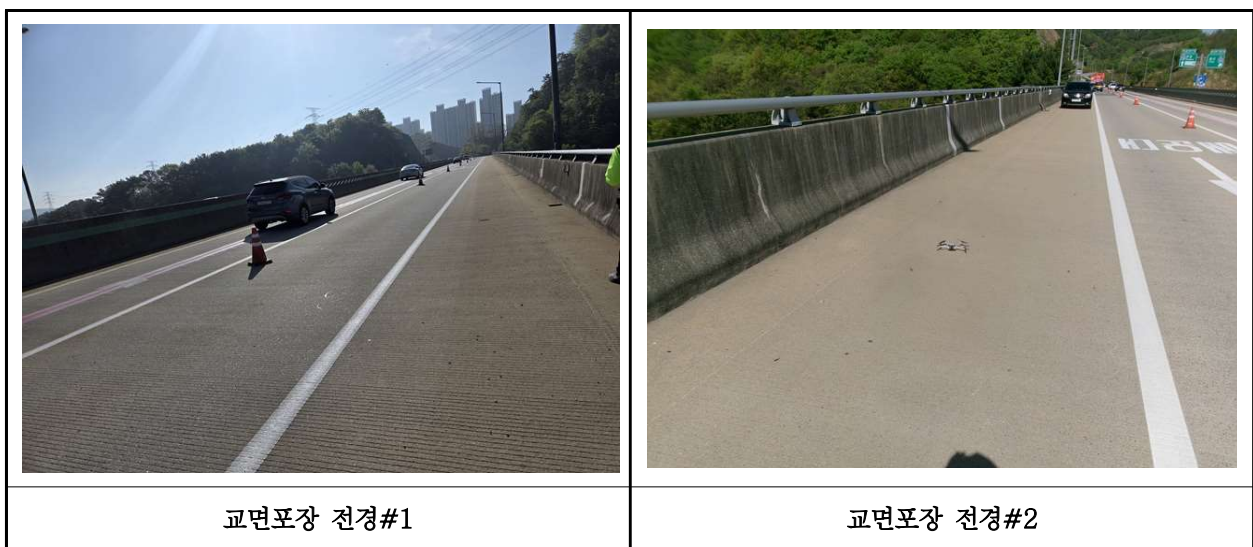
【사진 31.3.20】 교면포장 전경
