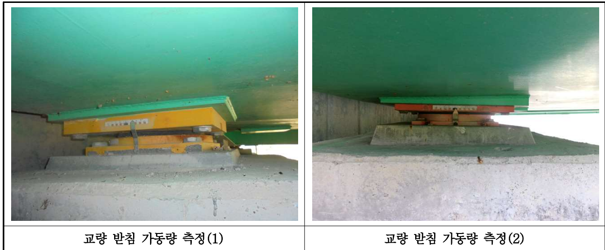
【사진 31.3.16】 교량받침 이동량 측정
