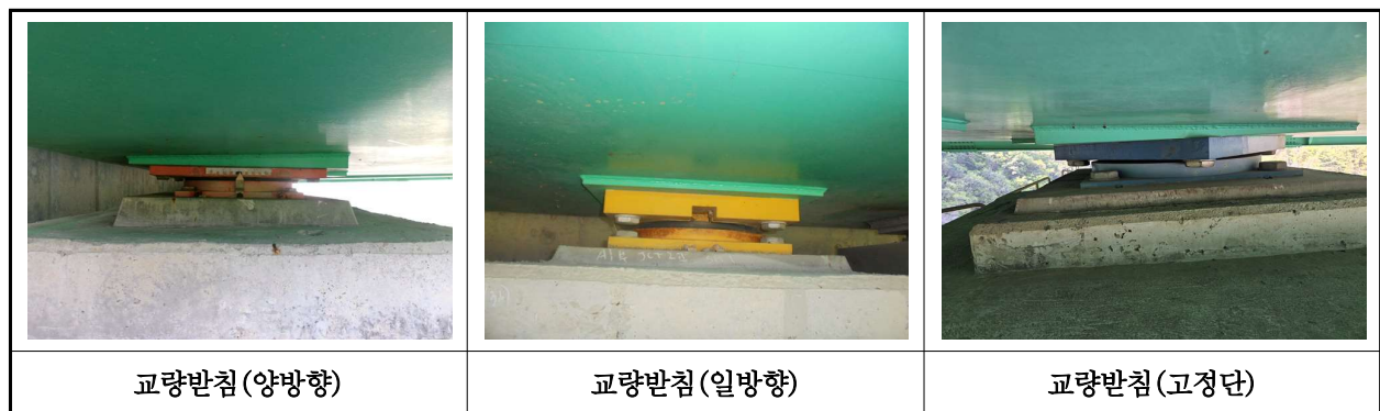
【사진 31.3.13】 교량받침 전경
